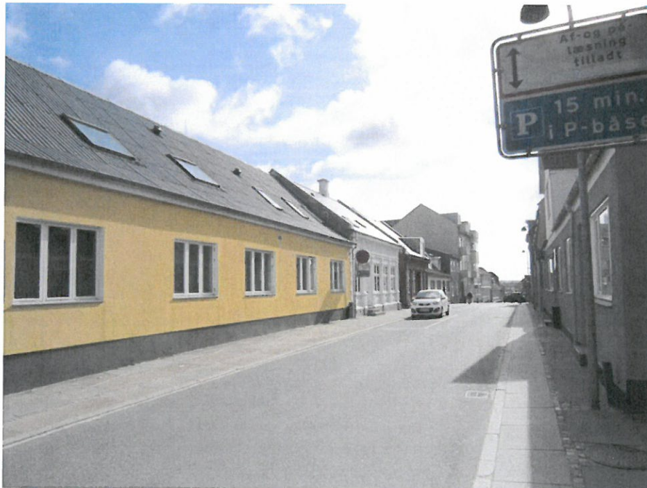
Bygning 1 (facade mod Storegade)
